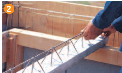
2 MONTAJE DE VIGUETAS. Se colocan a partir del muro de arranque y a la separación que se indica en el plano de montaje.
