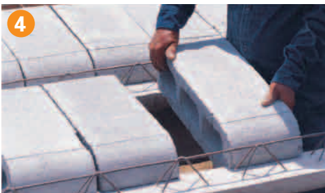
4 MONTAJE DE BOVEDILLAS. Se colocan las bovedillas, procurando que queden bien asentadas y ajustadas, tanto como sea posible.
