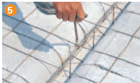
5 COLOCACIÓN DE LA MALLA SOLDADA. Se corta al tamaño requerido y se amarra con alambre recocado a la varilla superior de las viguetas.
