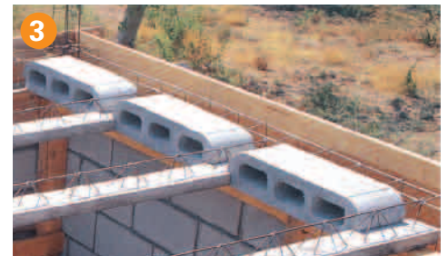
3 ALINEAMIENTO DE LAS VIGUETAS. Se colocan las bovedillas de los extremos para dar la separación correcta entre viguetas.
